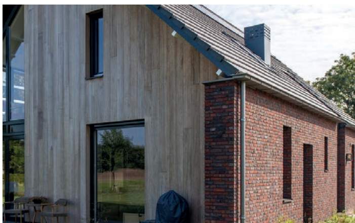
Rode baksteen met zwart dak en hout.
