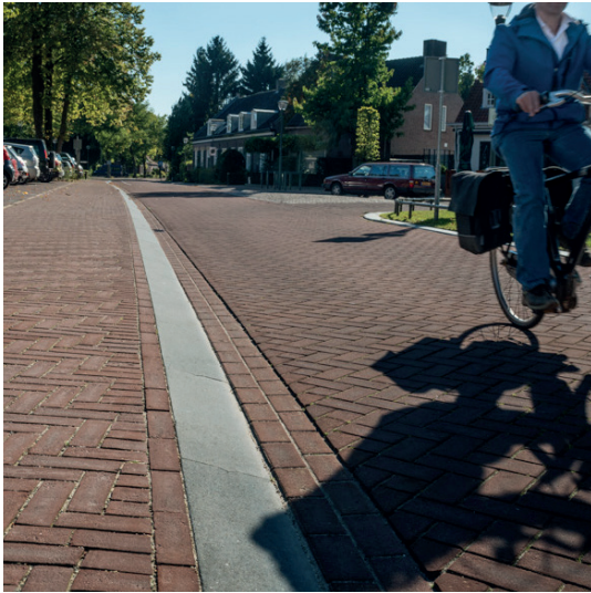
rijbaan: gebakken klinkers terra rossa keiformaat trottoirband: schuine band
