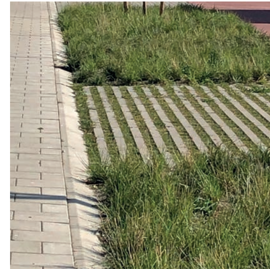
waterberging door minder verharding en een goede sponswerking van de bodem
